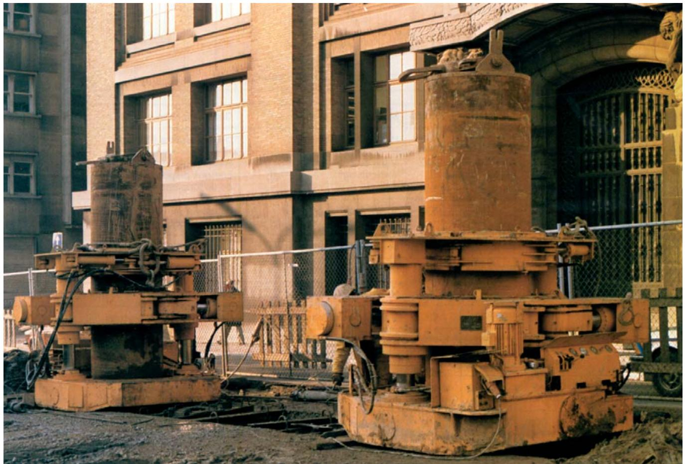
Rohrziehmaschinen 1200/350 mit Entkupplungsvorrichtung im Einsatz
