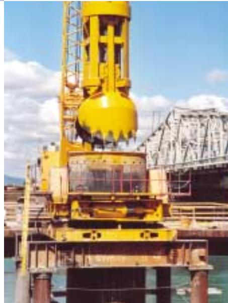
Wo sehr große Gründungstiefen und/oder große Bohrdurchmesser für Pfahlgründungen erforderlich werden, kommen LEFFER Baumaschinen in großem Umfang zum Einsatz. Zum Beispiel wurden bei fast allen Gründungsarbeiten der Wolkenkratzer Hong Kongs LEFFER Maschinen eingesetzt.
