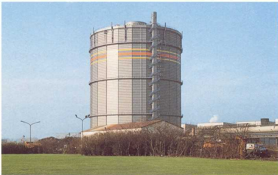
LEFFER Scheibengasbehälter Typ M.A.N. Thyssen Stahl Duisburg, Deutschland Inhalt: 100000 m 3
